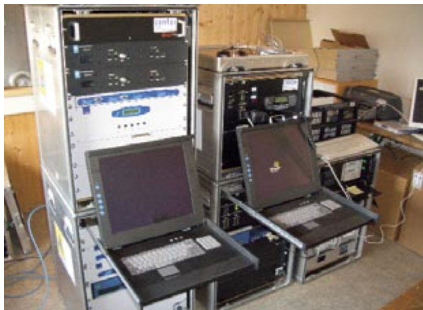
Abb. 4: Sämtliche Systeme stehen als mobile Einrichtung zur Verfügung
